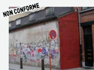
Rez-de-chaussée non conforme car comportant moins de 20% de baies ou autres ouvertures.
