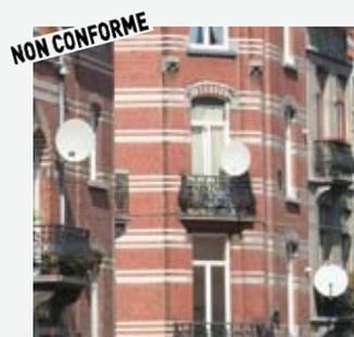
Situation non conforme : antennes paraboliques disposées sur la façade à rue.
