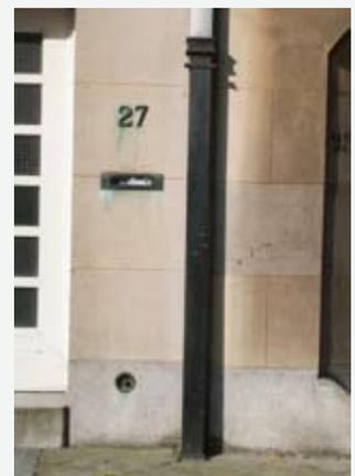
Descente d'eau de pluie apparente munie d'une souche pluviale de 1 mètre de haut minimum.
